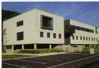
Bureaux de la communauté de communes des Deux Rives à Saint Vallier (26) Architectes : A.Girardet (26), B.Cogne (26)
