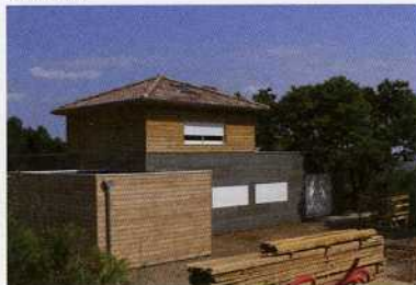
Construction d'une habitation à Vernon (07) Architecte : Pascale Guillet (07)
