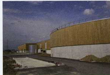
Centre de valorisation des déchets ménagers à Etoile sur Rhône (26) Architecte : S'Pace (94)
