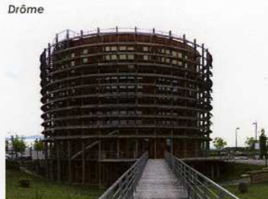
Extension du Syndicat Départemental d'Energies de la Drôme à Alixan (26) Architecte : André Solnais (26)
