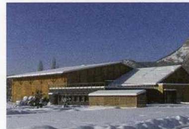
Herbier du Diois à Châtillon-en-Diois (26) Architecte : Vincent Rigassi (38)
