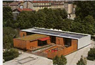
Construction de la crèche Philippeville à Grenoble (38) Architecte : r2k (38)
